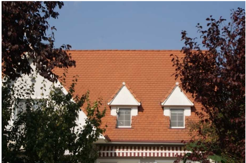
Rákóczi utca 250/3 hrsz. – két színre komponált homlokzat és tető: hódfarkú téglaszínű cserépfedés, fehér tetőablaksíkok és keretek. A kihúzható napernyő vászna is ehhez az egyszerűséghez illeszkedik...
