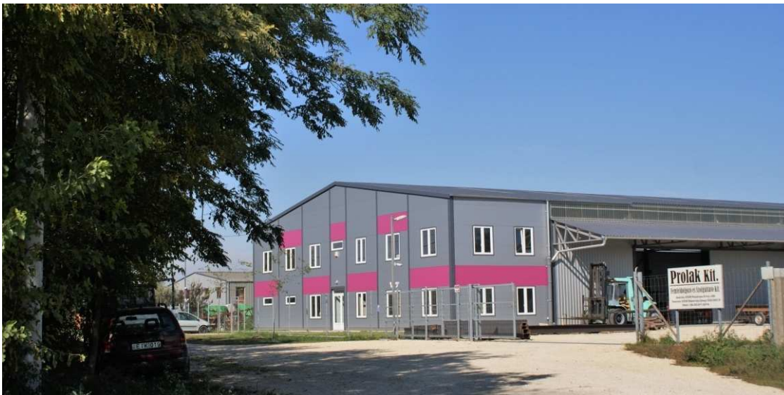
A Prolak Kft. új épülete a bekötő útra kapcsolódó kiszolgáló út mentén létesült, megbújva a bekötő út menti erdős terület mögött
