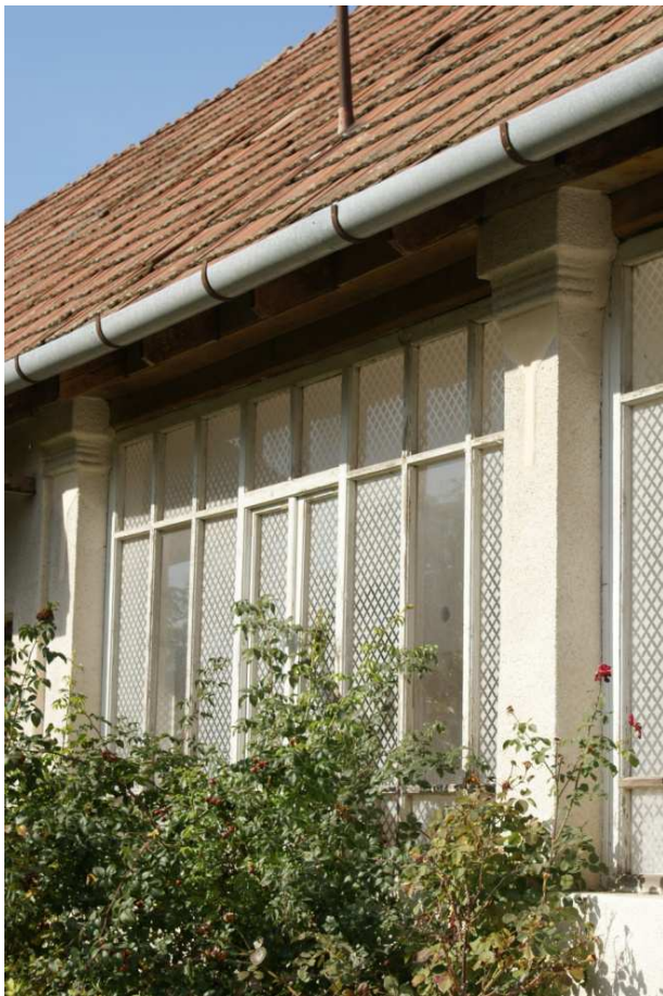
Veranda, tornác beüvegezve, Kossuth utca
