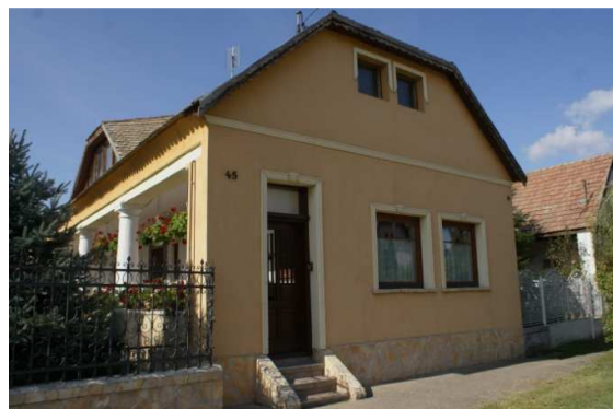
Régi hosszúház új, tetőtéri funkcióval, új építészeti elemekkel, Kossuth u. 45.
