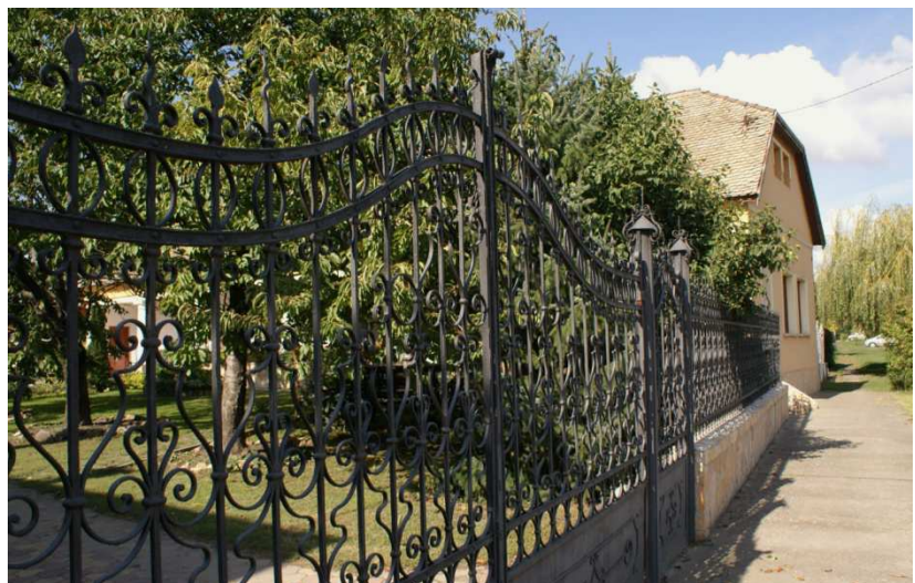
Régi szép, szakszerűen felújított kovácsoltvaskerítés, nagykapúval, kiskapúval, mögötte gondozott kerttel, felújított, bővített „hosszúházzal”, Kossuth utca 144/1 hrsz.
