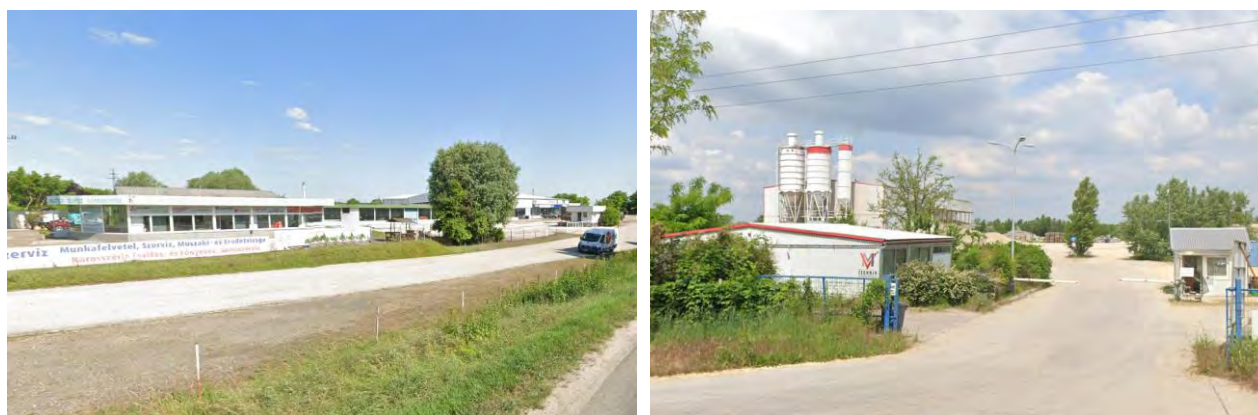
A főút nyugati oldalán lévő telephely (balra) és a keleti oldalán lévő üzem (jobbra) épületei (forrás: maps.google.com)
